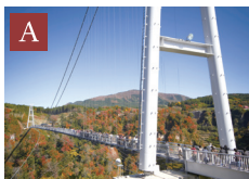
九重“夢”大吊橋
